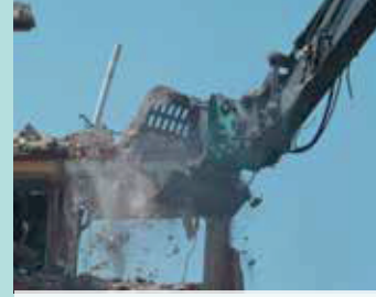
RENOVASYON VE YIKIM UYGULAMALARI
