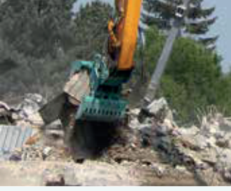
RENOVASYON VE YIKIM UYGULAMALARI
